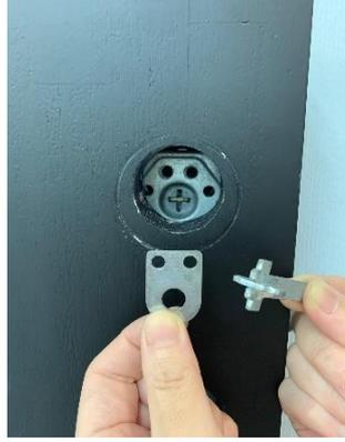
⑪室内側からネジを締めシリンダーを固定します。テールピース（板状の部品）は横です（下左図）
